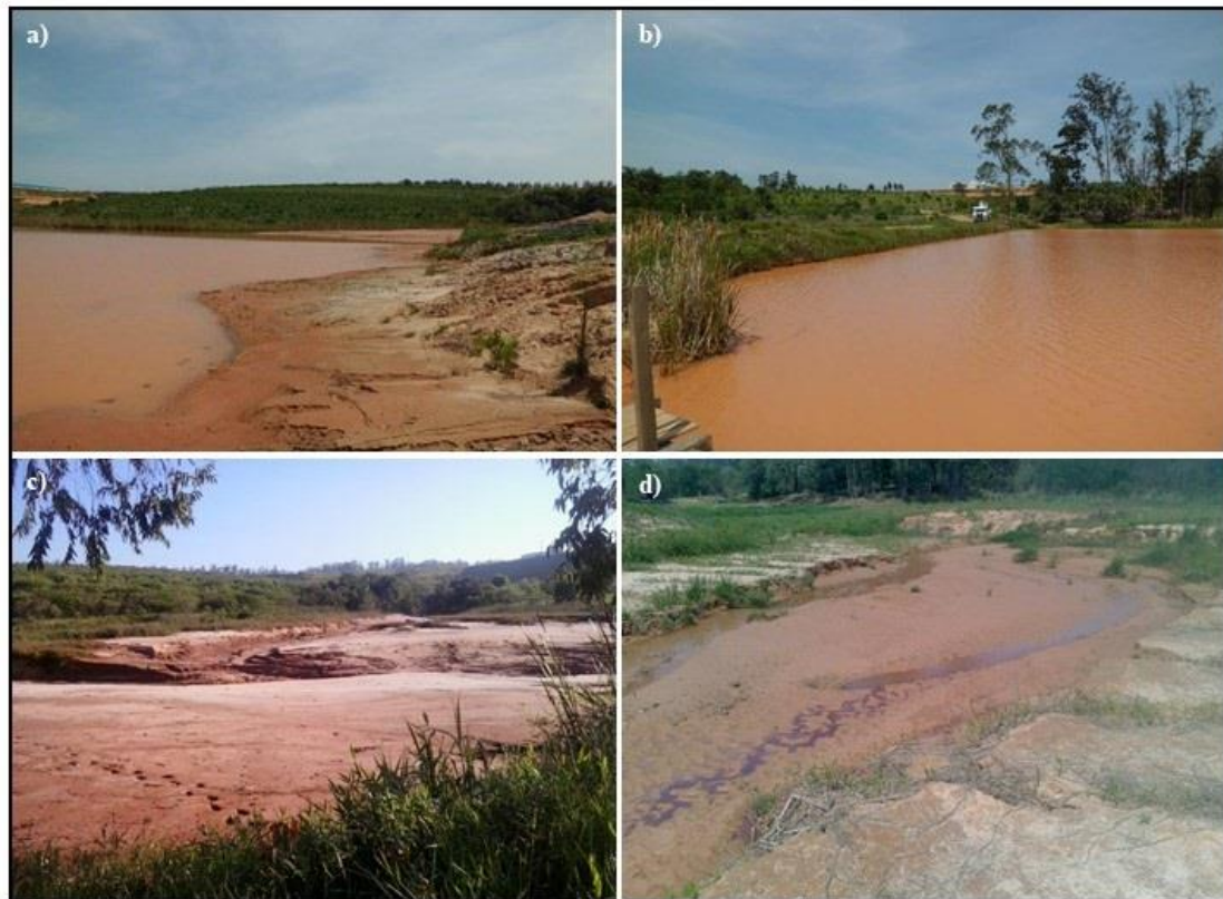
Figure S2 - Campininha stream in the periods before and after the dam rupture, evidencing (a) and (b) the reservoir with erosion in the banks; (c) reservoir area and (d) stream stretch, post dam rupture. - Riacho da Campininha nos períodos antes e após o rompimento da barragem, evidenciando em (a) e (b) o reservatório com erosão nas margens; (c) área do reservatório e (d) um trecho do riacho após a ruptura da barragem. Source: Adapted from Moreira (2016)
